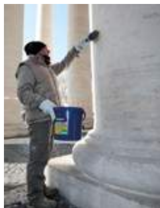
Application de ProtectGuard® par la société Pelicoat et les services techniques du Vatican.
